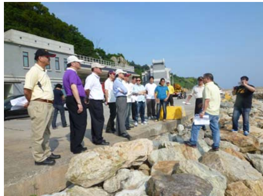
考察介壽澳口防坡堤現況
