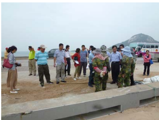
考察塘岐澳口及塘后道改善工程
