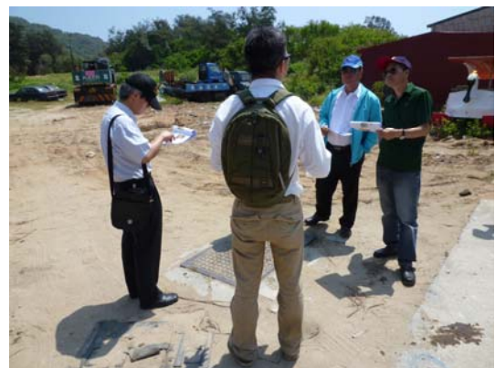
考察北竿衛生所新建大樓工程
