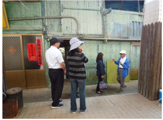
考察舊鄉公所及對面民宅拆除工程及拜會鄉公所
