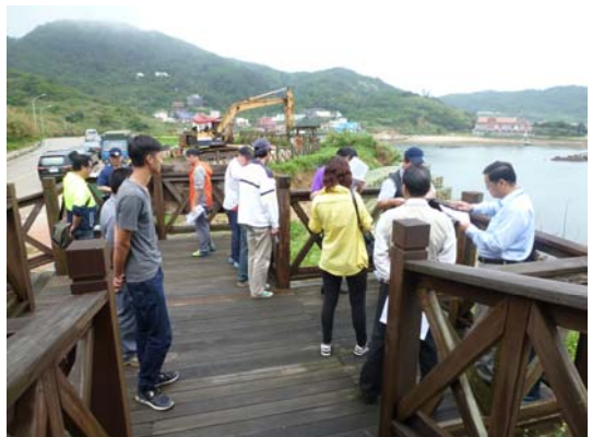
考察南竿鄉珠螺海岸環境改善工程
