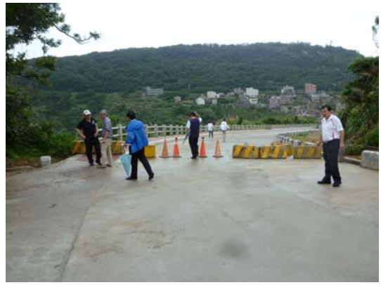
考察南竿鄉復國路交通改善工程
