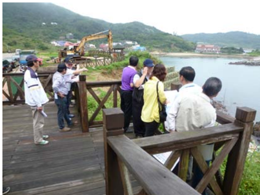
考察南竿鄉珠螺海岸環境改善工程
